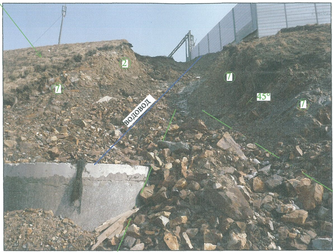
ТН-1. Северо-западный угол участка работ, подножие откоса
