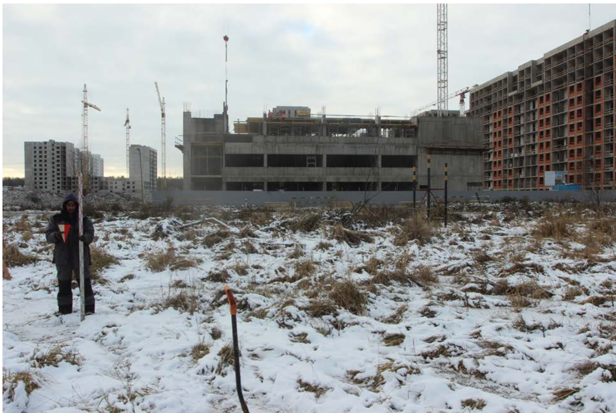
Рис. 23. ЛО, Новоселье-2023. КН: 47:14:0504001:7768. Точка фотофиксации 3, вид на юг.
