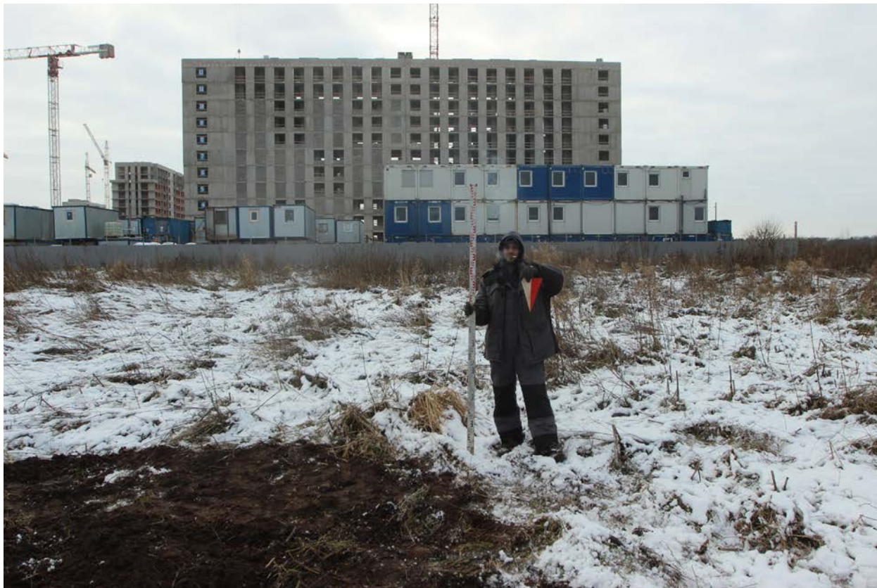
Рис. 14. ЛО, Новоселье-2023. КН: 47:14:0504001:7768. Точка фотофиксации 1, вид на юг.
