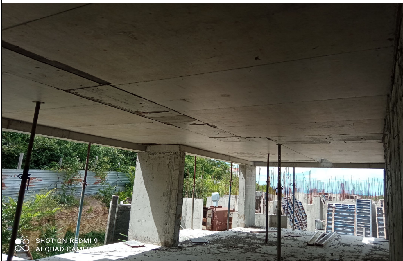
Фото В.5 Общий вид этажа на отм.+2,900
