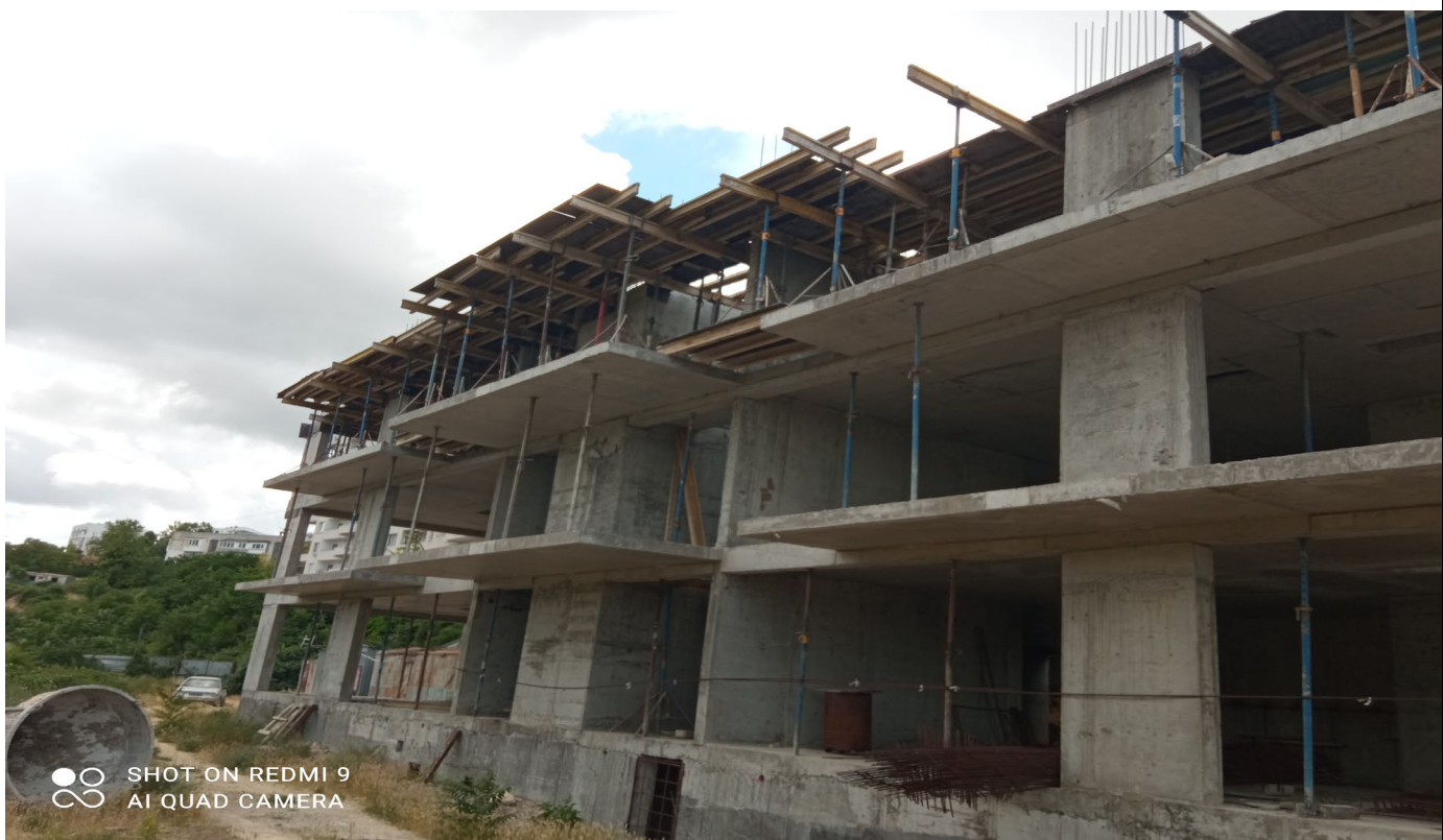
Фото В.2 Фрагмент северного фасада здания в осях 1-7
