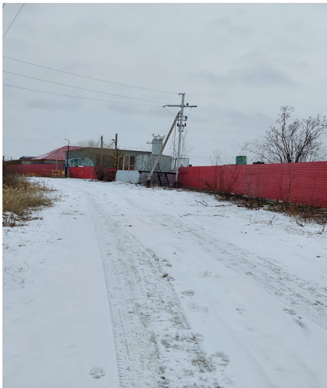
Проезжая часть на северной части
