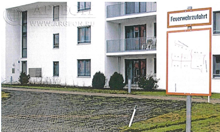
Пожарный проезд в Германии
