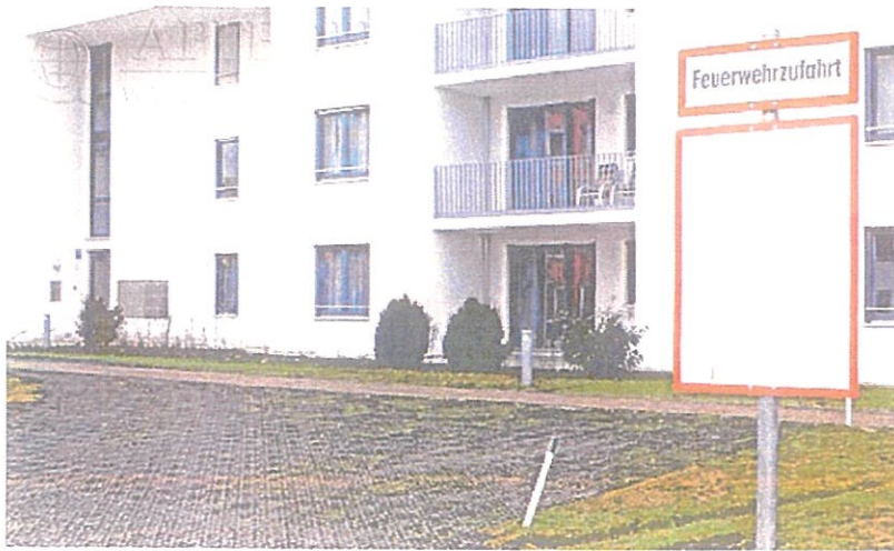
Пожарный проезд в Германии
