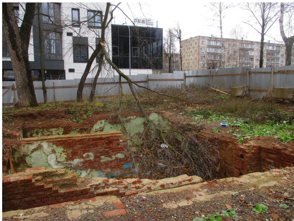
Фото 2– подвал и остатки фундаментов снесённого жилого дома
