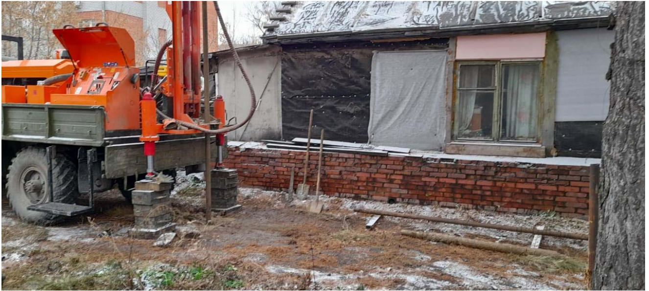
Фото 1. Бурение скважины
