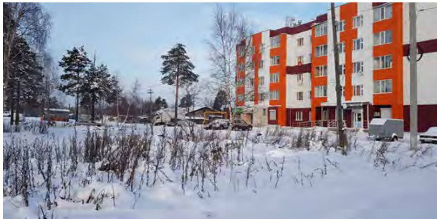
Рисунок 5.6, 5.7 – Жилые дома вблизи района работ
