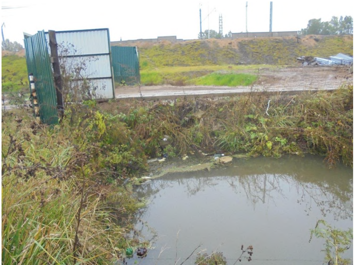
Фото 9. Нижний бьеф водопропускного сооружения под ул. Вокзальной
