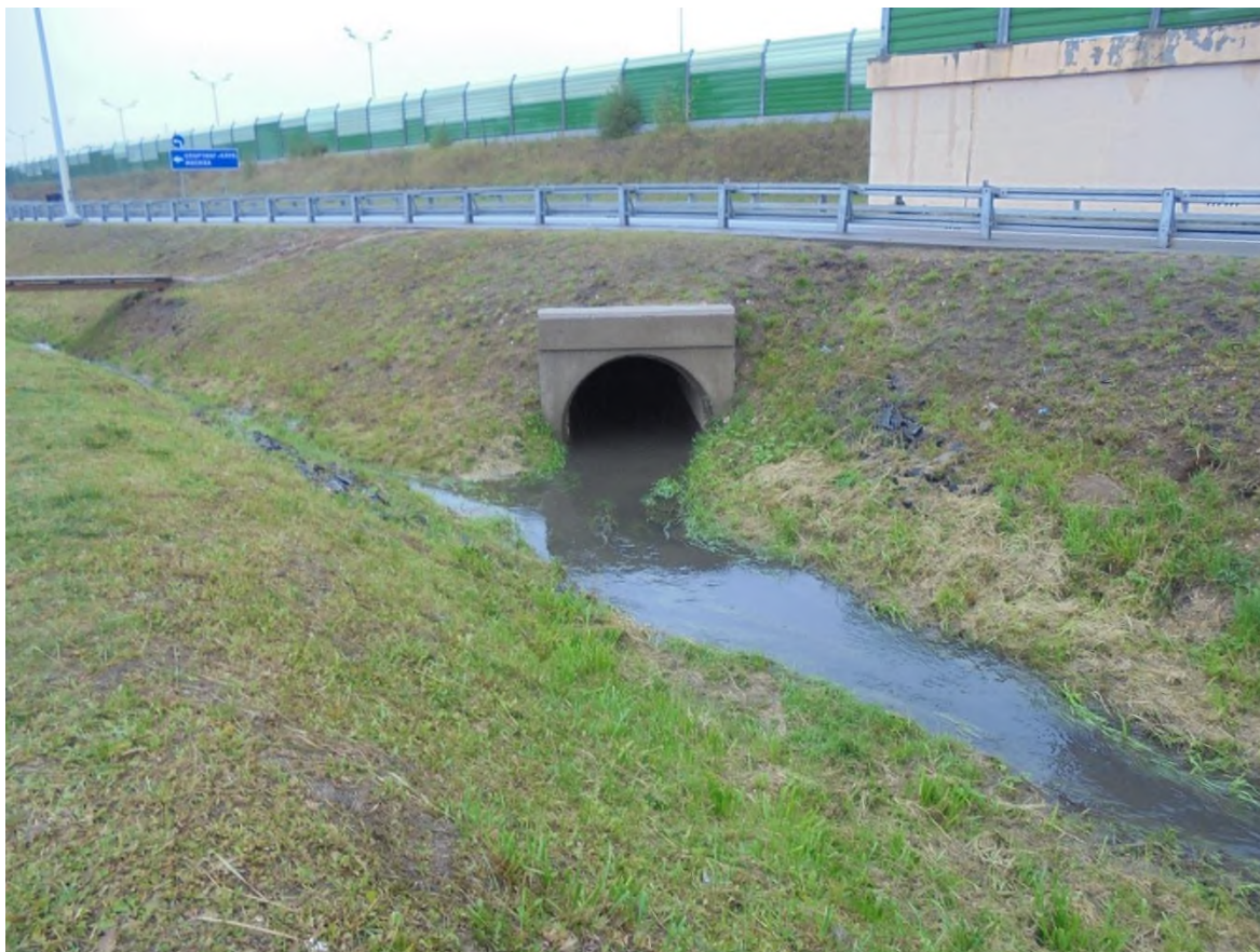
Фото 1. Выходной оголовок водопрпускного сооружения под Минским шоссе
