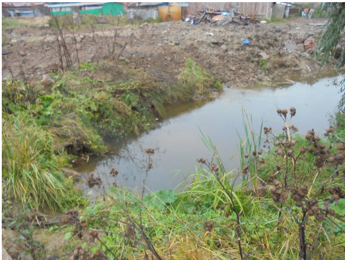
Фото 6. Нижний бьеф гидроузла пруда
