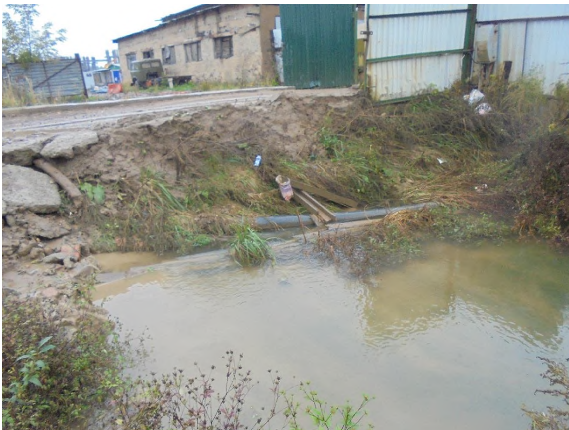
Фото 8. Верхний бьеф водопропускного сооружения под ул. Вокзальной
