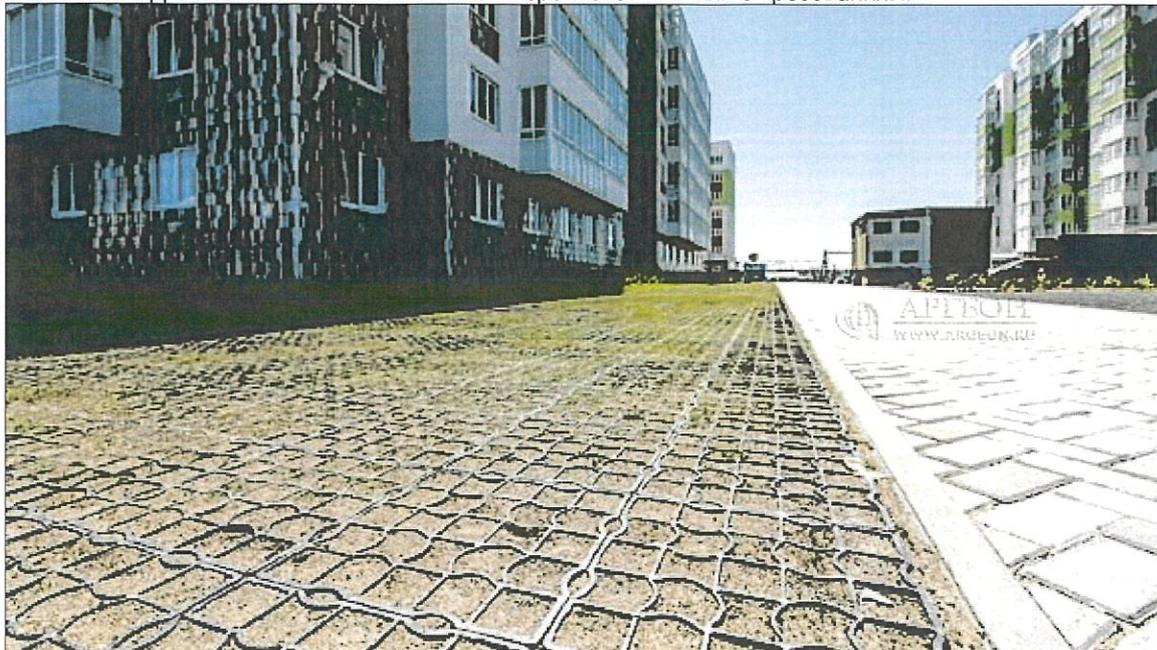
**По результатам испытаний 2016 г. она выдерживает до 23,5 тонн на ось (до 350 т/м<sup>2</sup>)** при заполнении ячеек растительным грунтом (результат испытаний предоставляется по запросу). Без заполнения ячеек результаты испытаний показали 22,4 т/ось.
