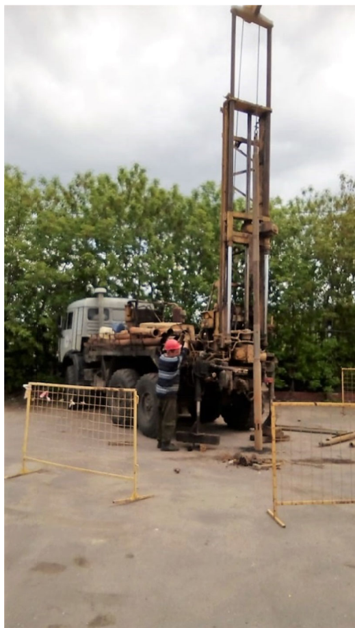
Рисунок 2 – Проведение инженерно-геологических изысканий на объекте
