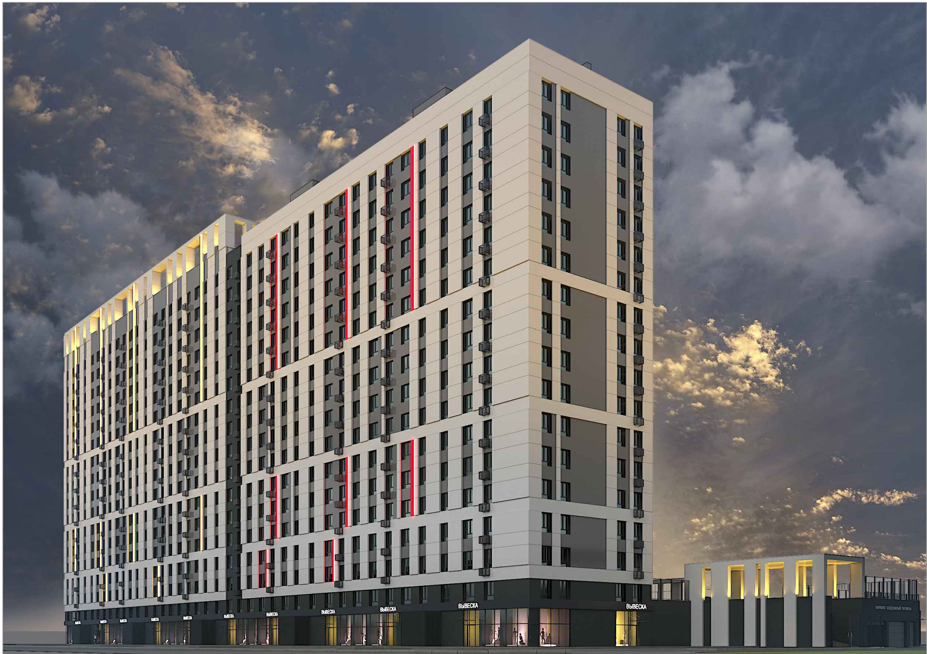
Архитектурное освещение фасада, вид с улицы 30 лет Победы
