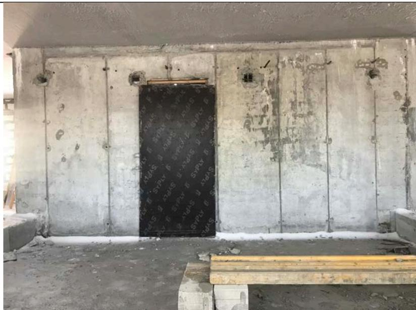
Секция 5. Ядро жесткости стена по оси 25-26/И. Поверхность бетона с пустотами шириной до 1 см. глубина до 0,5 см
