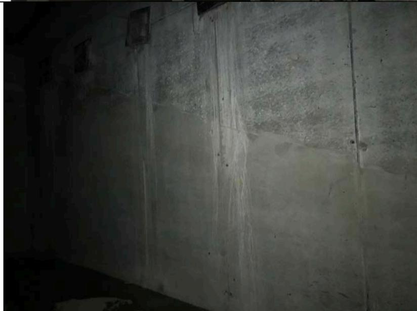
Секция 6. Косой шов бетонирования стена ядра жесткости 31/Д-И
