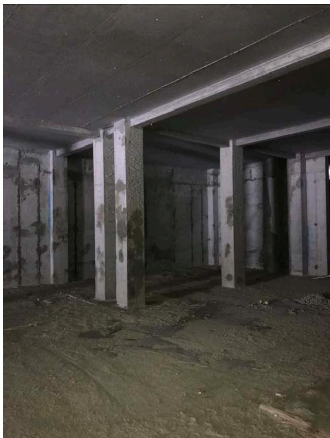
Секция 4-5. Общий вид на колонны по оси 22, 23 диафрагму по оси 24. Следы устранения пустот цементно-песчаным раствором.
