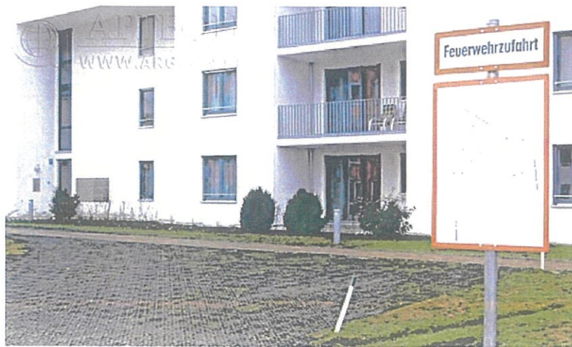
Пожарный проезд в Германии
