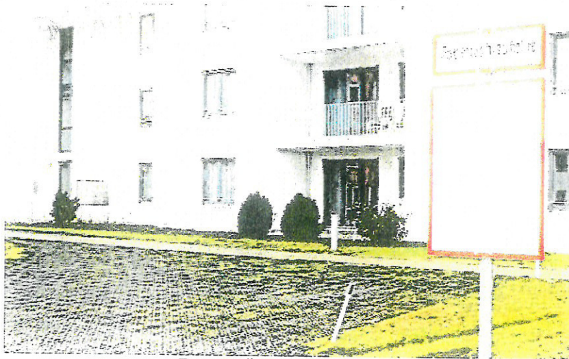
Пожарный проезд в Германии
