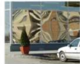
Рисунок 1. Эффект волны (визуальное искажение стекла из-за прогиба наружного стекла.
