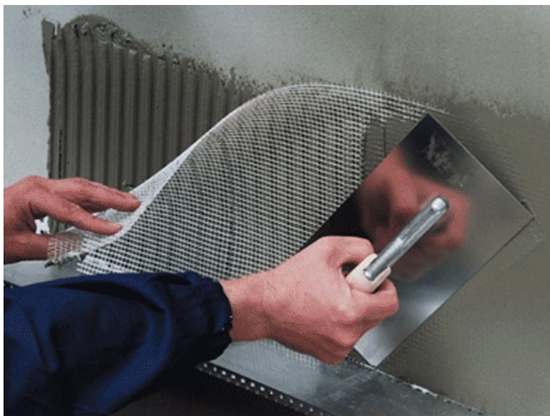
Рис. 25. Крепление армирующей сетки к утеплителю
