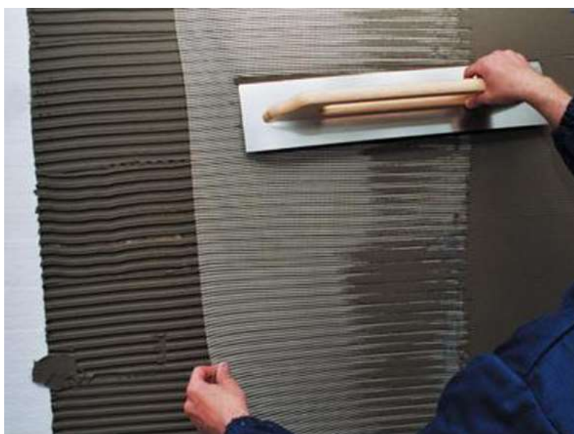
Рис. 26. Крепление армирующей сетки к утеплителю.
