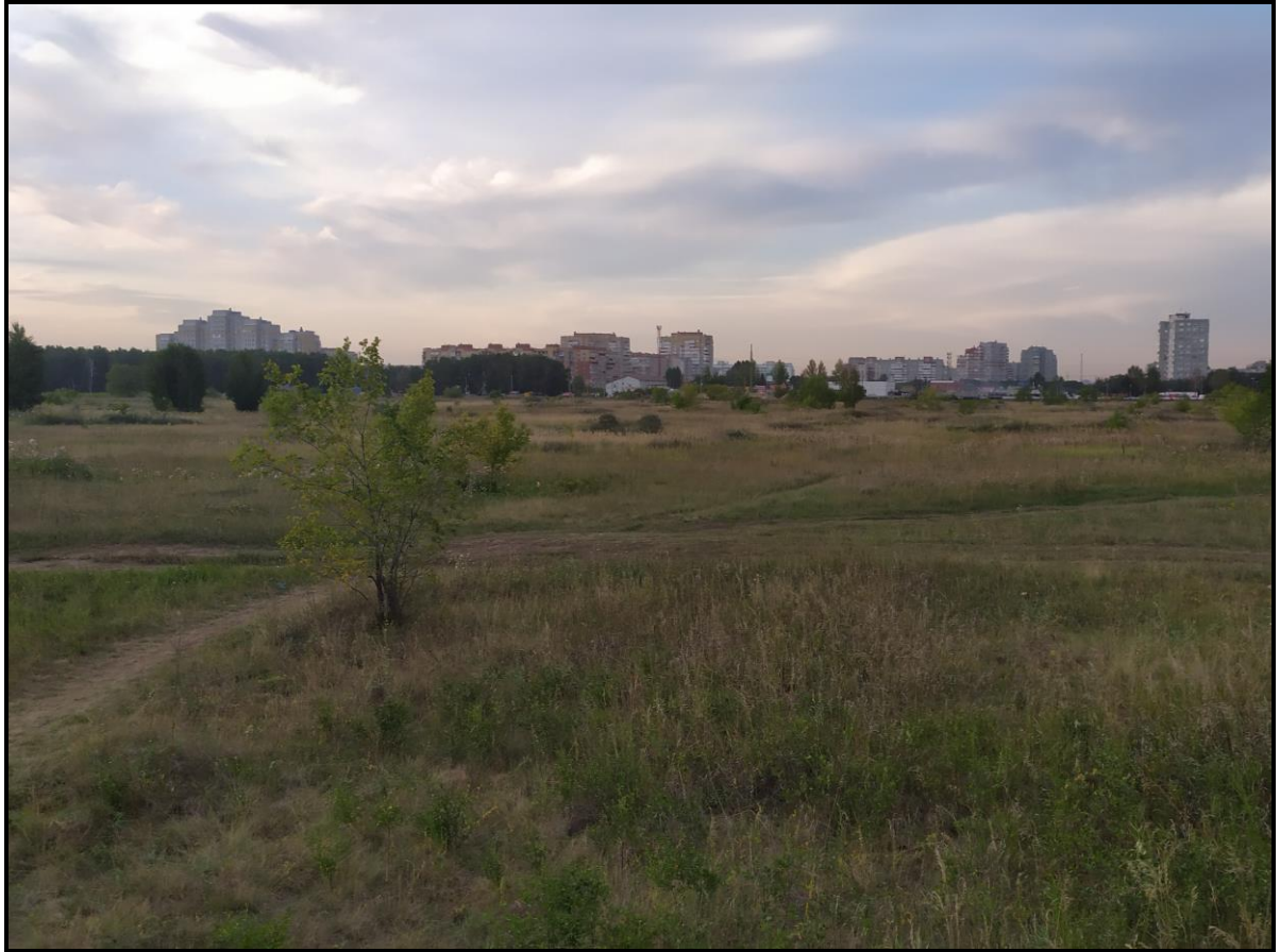
Рисунок 8.8 – Вид на участок производства работ
