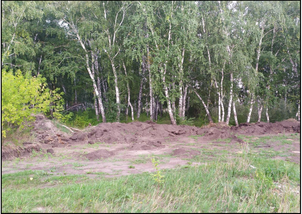
Рисунок 8.4 – Вид на участок производства работ
