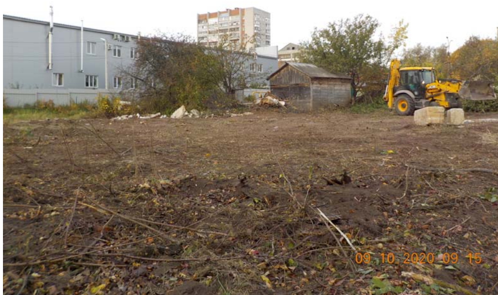
Фото № 1 Общий вид площадки
